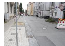
Sanierungsarbeiten in der Schloßhofstraße
