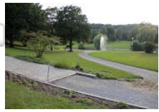
Umbauarbeiten im Bürgerpark
